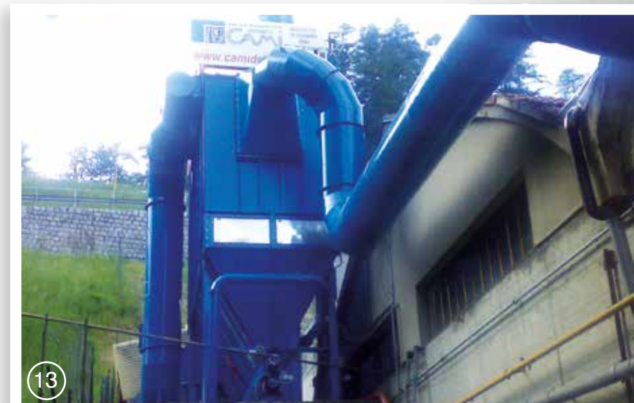
Filtro fumi ATEX per forno alluminio / ATEX fumes filter for aluminium kiln
