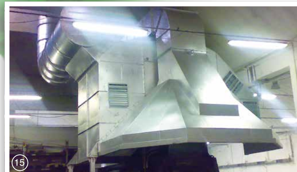
Cappa aspirazione forno fonderia di alluminio / Suction hood for aluminum foundry kiln
