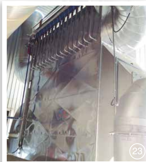
Scambiatori di calore con auto pulizia High efficiency - Heat exchanger with auto self cleaning
