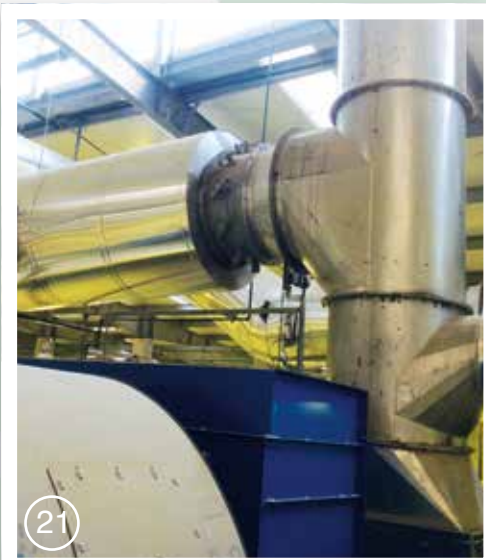
Gruppo di presa fumi/aria calda regolato Regulated fumes and hot air suction group
