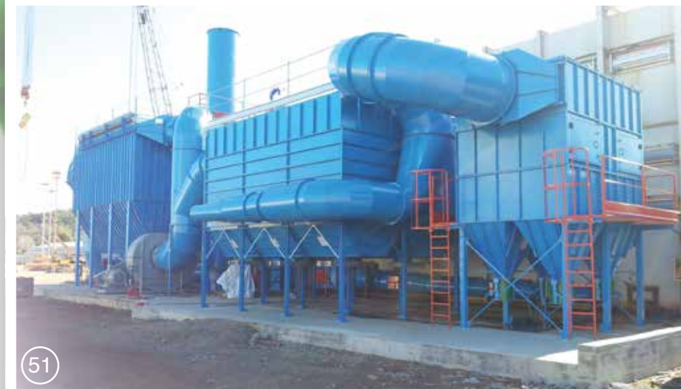
Filtro a maniche autopulenti con unità di abbattimento SOV Automatic sleeve filter unit with carbon filter for COV
