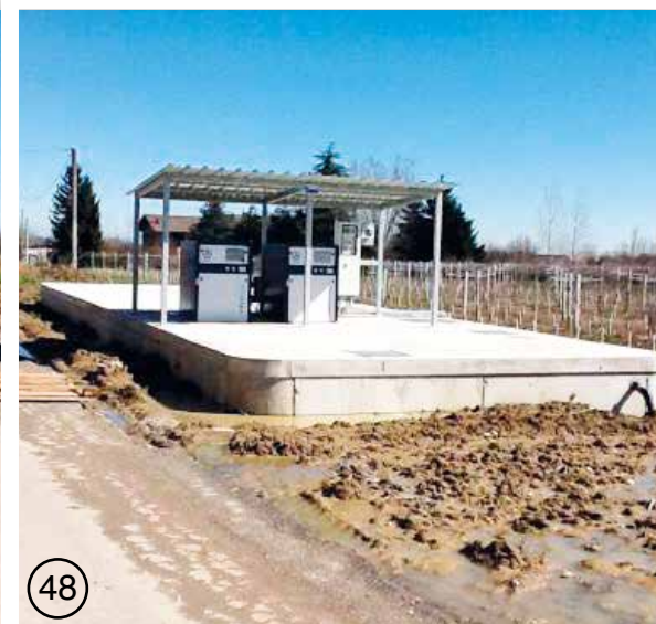
Impianto SBR / SBR System
