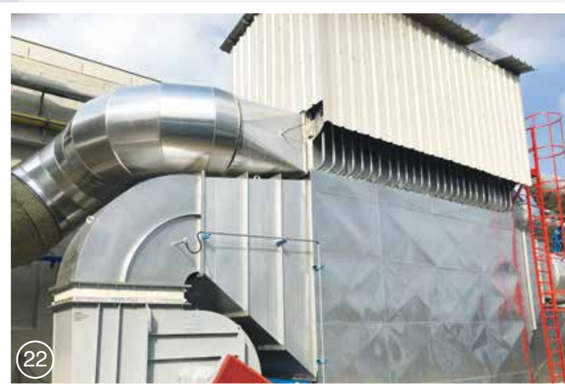
Scambiatori di calore con auto pulizia High efficiency - Heat exchanger with auto self cleaning
