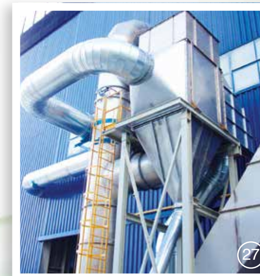
Scambiatore per recupero aria calda da fumi atomizzatore Heat exchanger for energy recovery from spray dryer fumes
