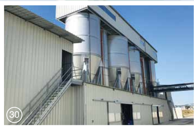
Impianto di depurazione e filtrazione acque reflue Waste water treatment plant and automatic filter presses
